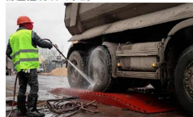
Wheel Wash Area 洗輪區
